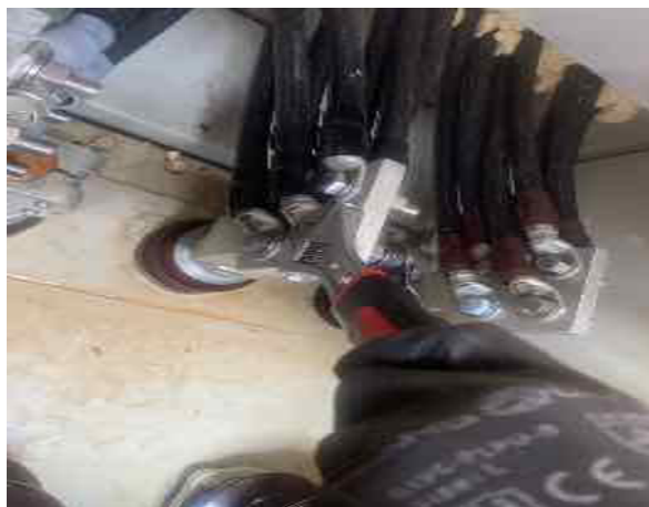
ชั้นอัดฉนวนต่อสายไฟฟ้าด้านแรงต่ำ
